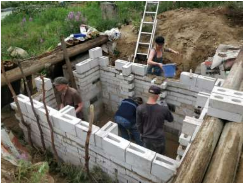
Maakellarin seinät nousevat.
