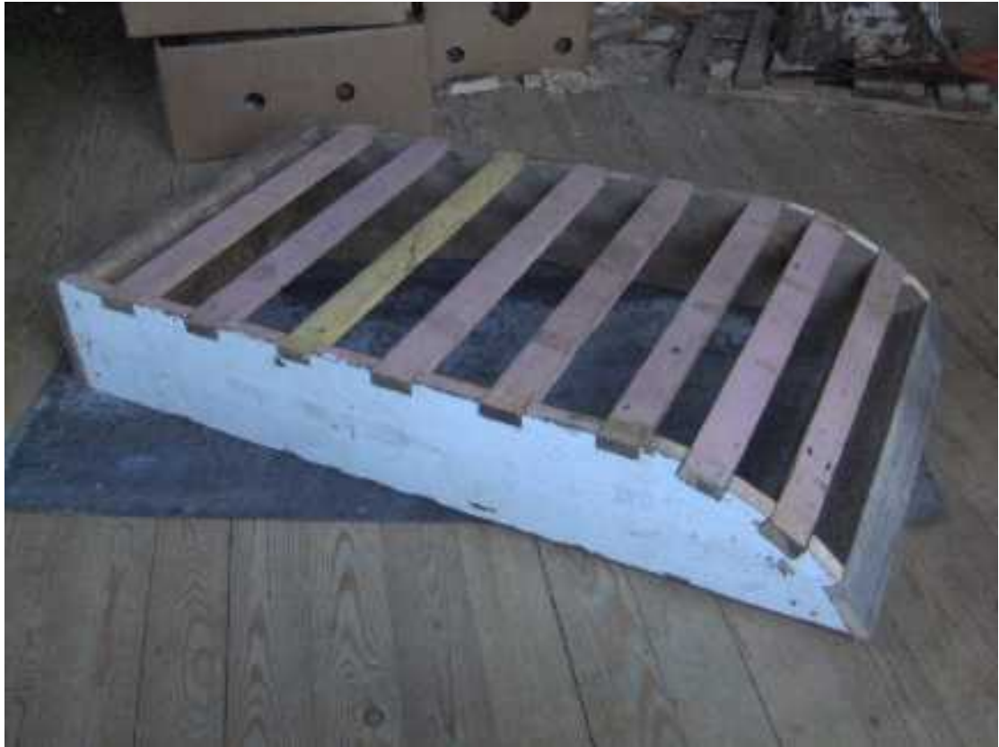
Pohjaruoteet on upotettu loviin ja naulattu kiinni.
