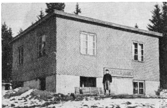
Kuva 58. Rappausta varten tikutettu lautarakennus.
