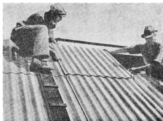
Kuva 114 (vasemmalla). Vanhaa pärekattoa peitetään asbestisementtilevyillä (Eternit)
