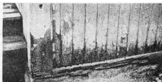
Kuva 35. Lannoitettu kukkapenkki lahottaa rakennuksen alushirren muutamassa vuodessa. Kuva 36. Räiskyvesien ja maakosteuden pilaama seinä, sen alushirren muutamassa vuodessa.
