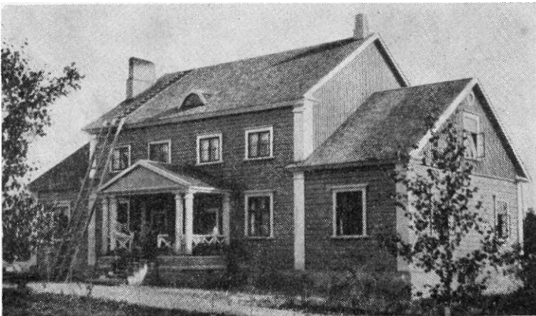
Kuva 75. Laudoittamaton rakennus, jossa vuorilaudat ja räystäät on huolellisesti suojattu ja niihin uhrattu hiukan muotoilua, joka lisää rakennuksen arvokkuutta.
