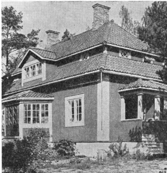
Kuva 106 (yllä). Polttotiilistä hyvin tehty katto.
