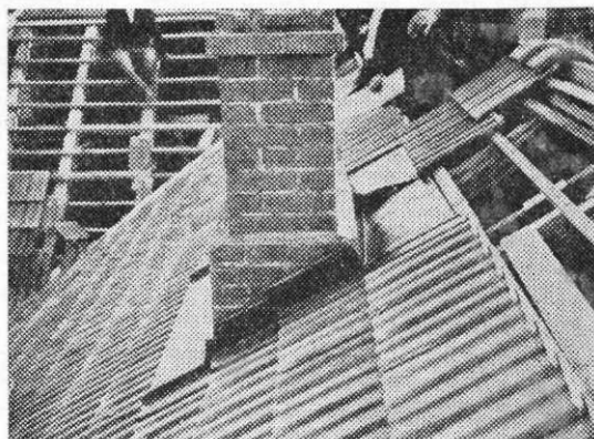
Kuva 109. Savupiipun juuri tiivistetään pellillä.
