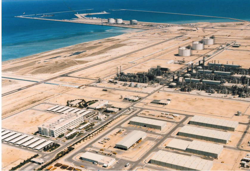
Shellin Pearl-hanke tähtää valtavan GTL-laitoksen (gas to liquids) rakentamiseen Ras Laffaniin (kuva) Qatariin. Laitos perustuu Fischer–Tropsch-teknoologiaan.
